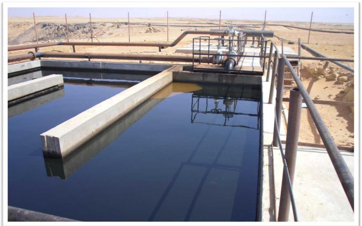
Figure IV.4 : bourbiers de décantation de l'eau de séparation
