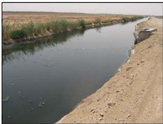
Fig.6.: Élargissement brusque des talus
