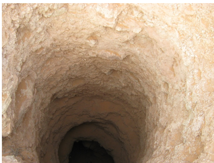
Photo.1. Puits de 11 m de profondeur tari après la diminution du niveau piézométrique.
