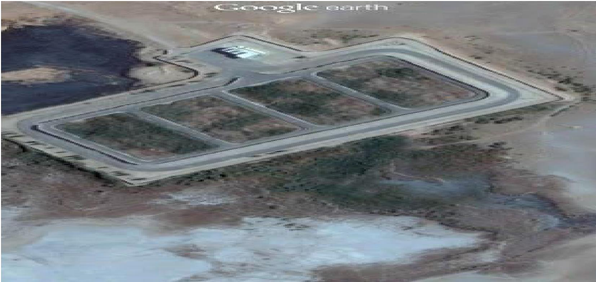
الشكل (18): منظر جوي لمحطة أنقوسة
