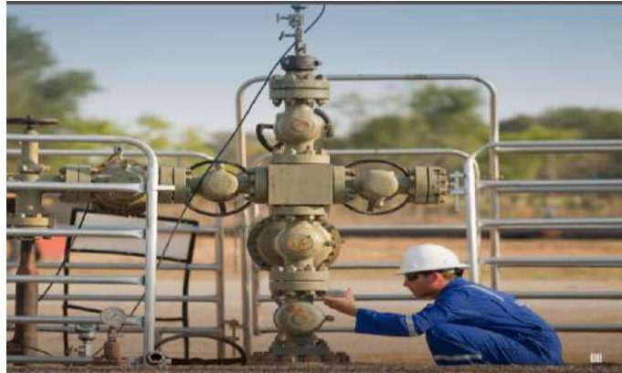
Fig. III. 10 : Tête de puits [11]
