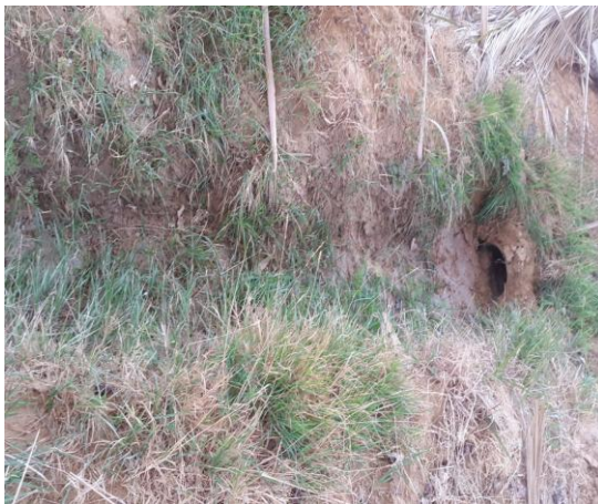
Photo n°6 : système d'irrigation par submersion (exploitation mauvaise entretien)
