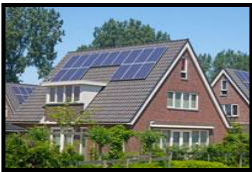
Figure I.13 : Panneaux photovoltaïques sur toit incliné de maison.
