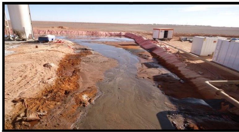
Figure III. 10: Bourbiers étanche en cours de forage
