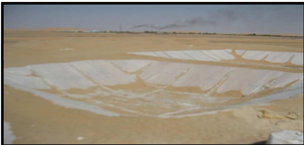
Figure III. 9: Bourbiers étanche avant le forage
