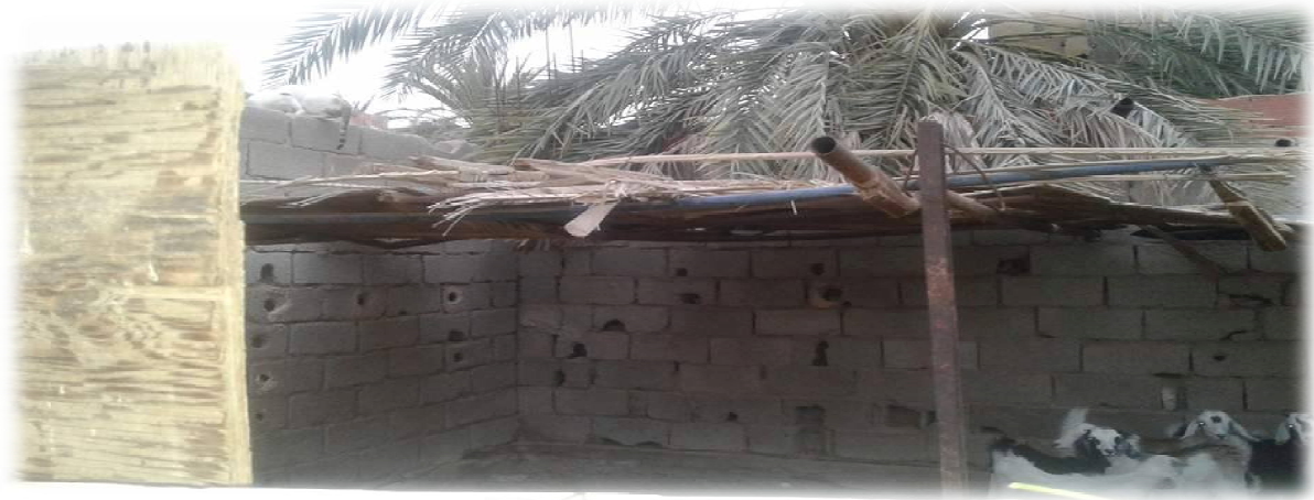
Figure 5: bâtiment d'élevage caprin
