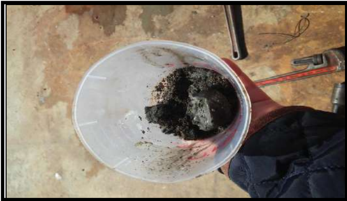
Figure III.33 : Faible dépôt de sédiments de sable
