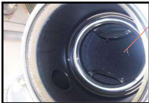
Figure III.16 : Dépôt remarqué dans les corps de filtres et aussi fond de cuve isotank
