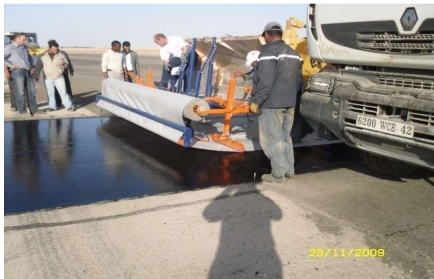
Figure IV.5: Mise en œuvre du géo-grille
