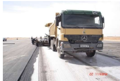
Mise en œuvre de la couche d'accrochage en émulsion
