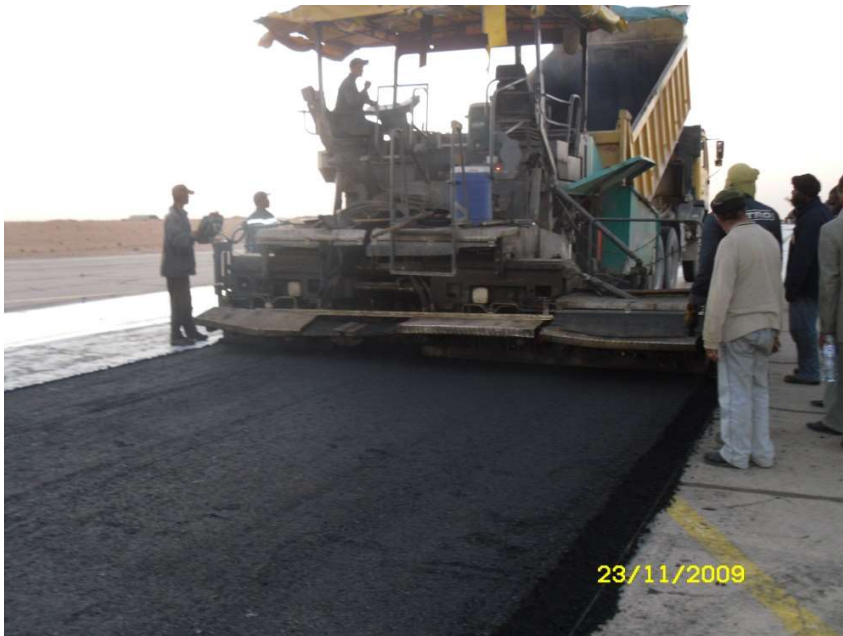
Figure IV .7 : mise en œuvre de l'enrobé à chaud 0/14
