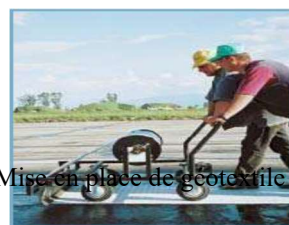
(Figure III.5) : Mise en place de géotextile
