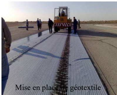
(Figure III.6) : Mise en place du Géo-grille à l'aérodrome de Ouargla
