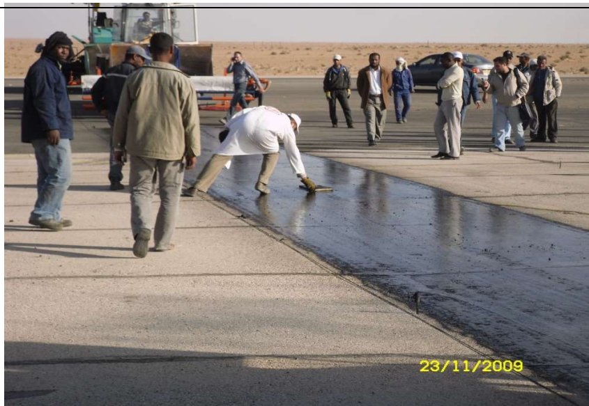
Figure IV.4 : Mise en œuvre de la couche d'accrochage en émulsion cationique 65%
