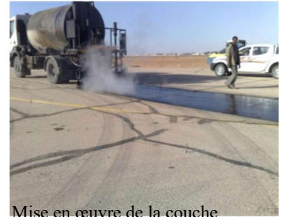
Mise en œuvre de la couche d'accrochage en émulsion
