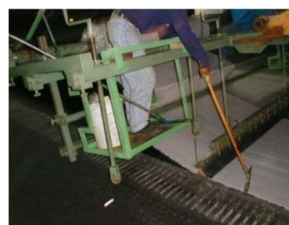
(Figure III.5) : Mise en place de géotextile
