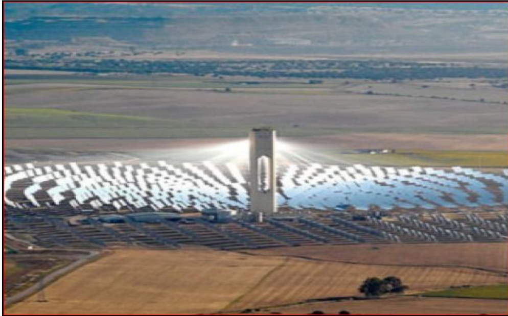
Figure 2.16 : Système de centrale à tour [12].
