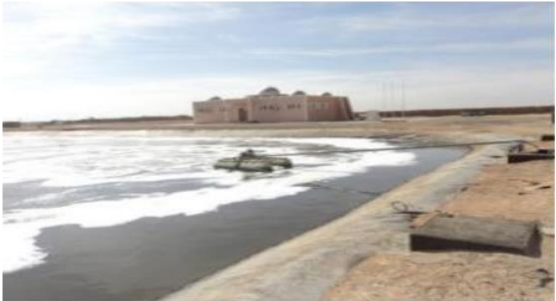
Figure (II-7): Lagune aéré.
