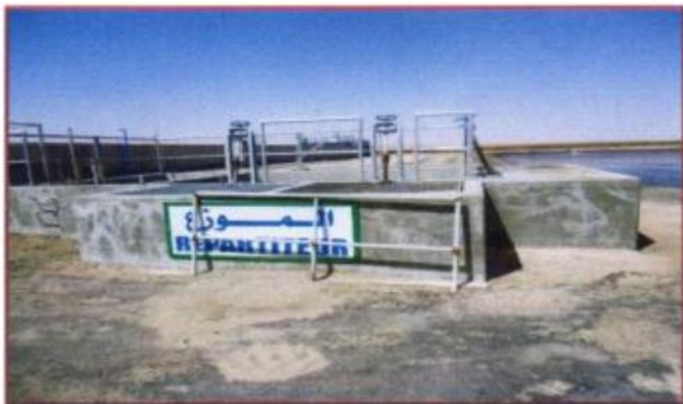
Figure (II-6): Répartiteur vers les bassins d'aération.
