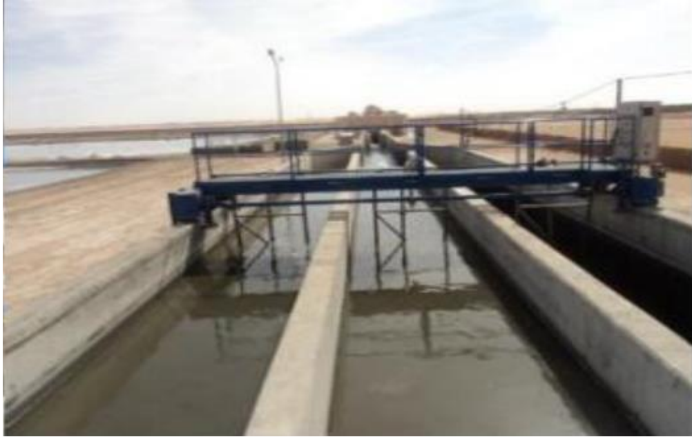
Figure (II-5): dessablage.
