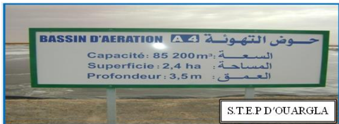
Annexe 5: lagune d'aération de premier étage.
