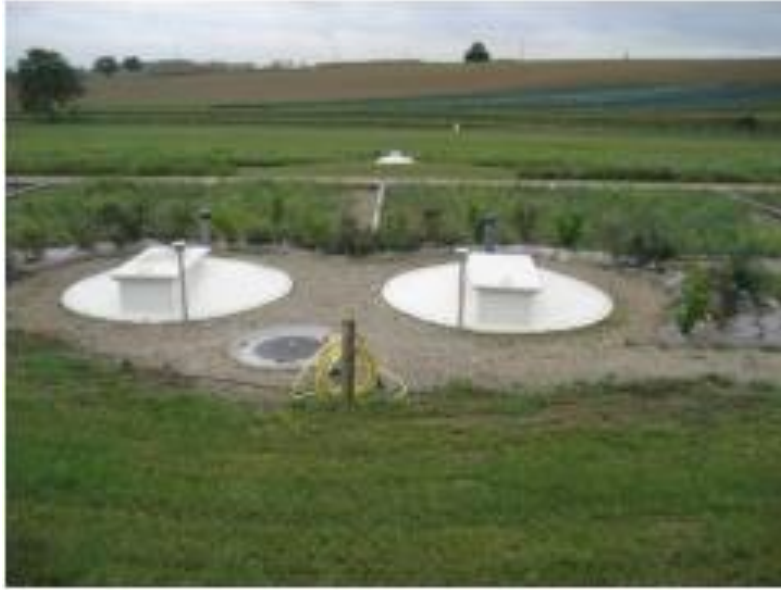
Figure (I-3): Le filtre planté de roseaux.
