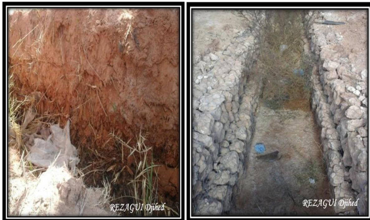
Photo IV 5 Drain à paroi de sol (A) et à paroi de pierre (B)
