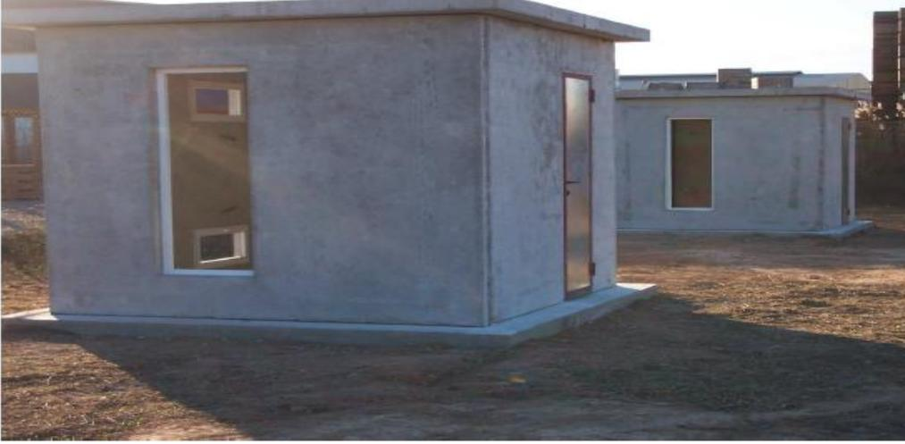
الشكل 9.IV.a. صورة لمبنى بالأبعاد (2.4mx2.4mx2.4m) (béton+MCP) [28.25]
