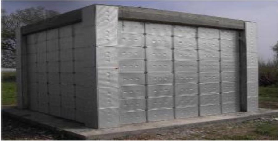
الشكل 9.IV.b. مبنى بعازل من البوليوريثان (polyuréthane) و MCP [28.24]
