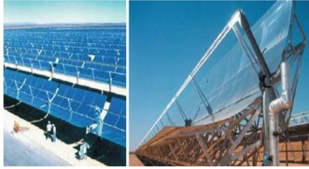
الشكل 4.II. أحواض ذو قطع مكافئ (Paraboliques) لتجميع الطاقة الشمسية [4]
