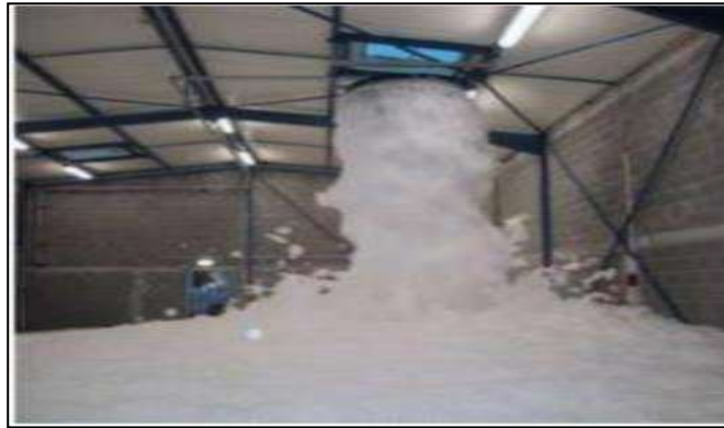
Fig. II.14: Extinction incendie avec la mousse [3]
