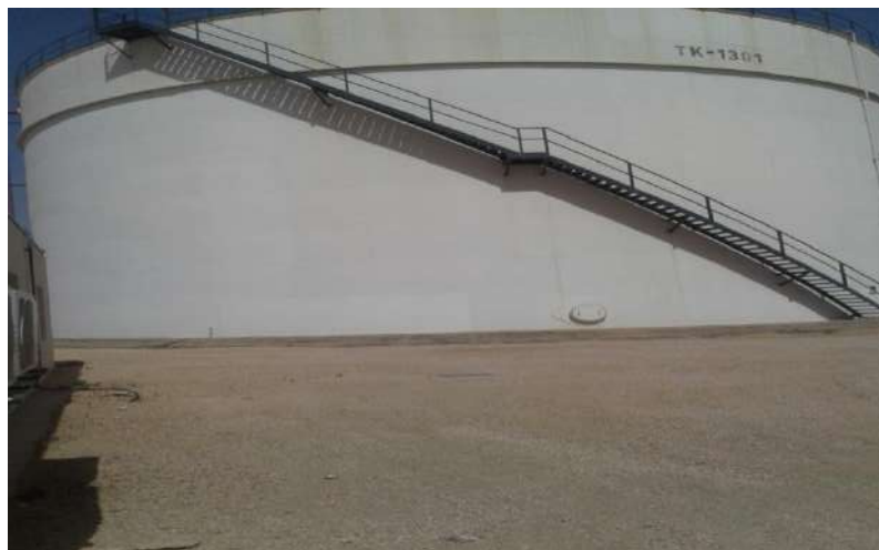
Fig. II. 13 : bac de réserve d'eau
