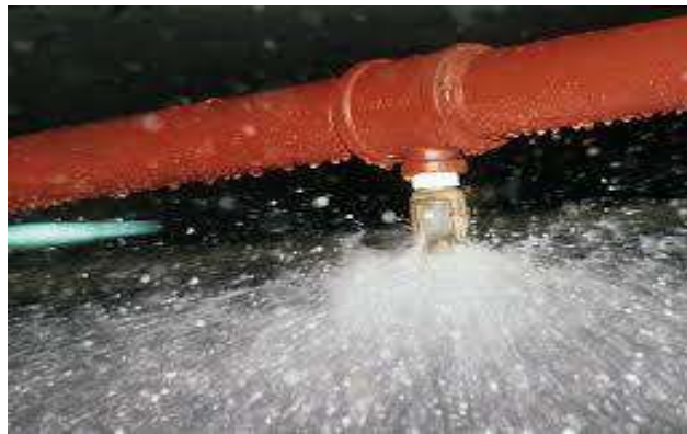
Fig. II. 11 : Le sprinklage [8]
