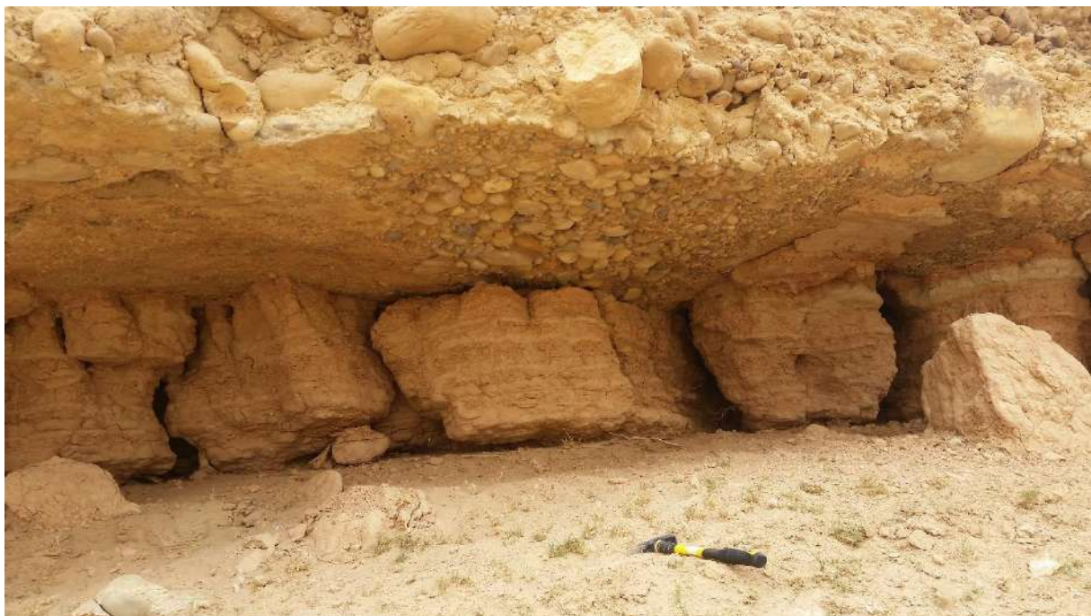
Fig. 31. Illustration photographique montrant des bancs de grés subis à une érosion d'encoche (sapement), surmontés par des conglomérats fluviale.
