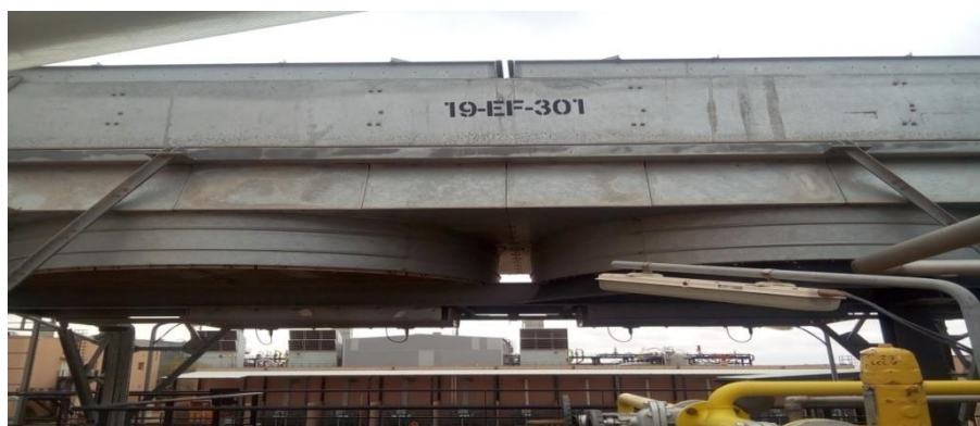
Figure I.16 : Aérocondenseur EF-301.
