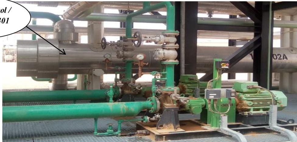
Figure I.11 : Echangeur glycol froid.
