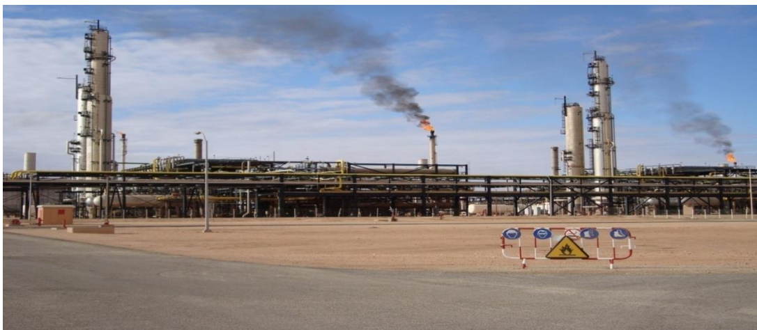
Figure I.3 : Module de traitement de gaz 1 (MPP1).
