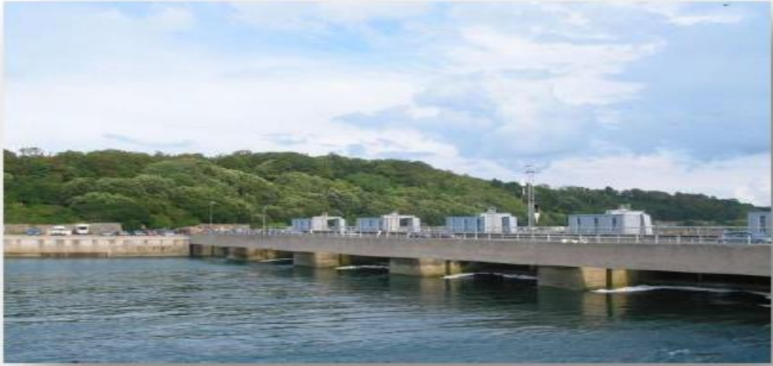
الشكل (2) : سد لتوليد الطاقة الكهربائية يعمل بطاقة المد و الجزر.
