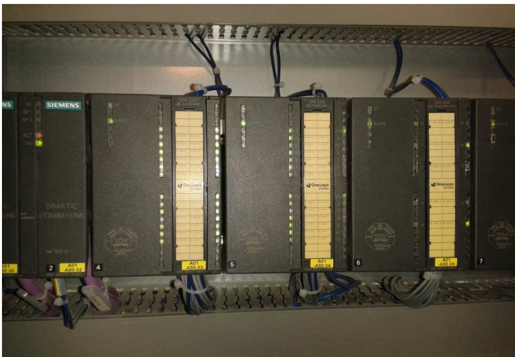
Figure IV.3 : Modules entrées/sorties de sécurité.
