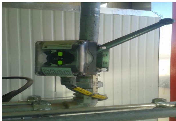
Figure II.9 : vanne mécanique avec fin de course.
