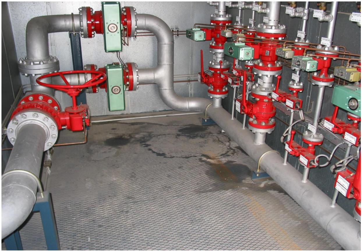
Figure 5 : Vue réel de surcuits de huile de lubrification.
