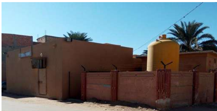
Figure I.3 : Station de pompage Douane 01
