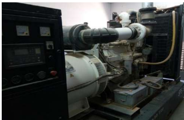
Figure I.21 : Groupe électrogène
