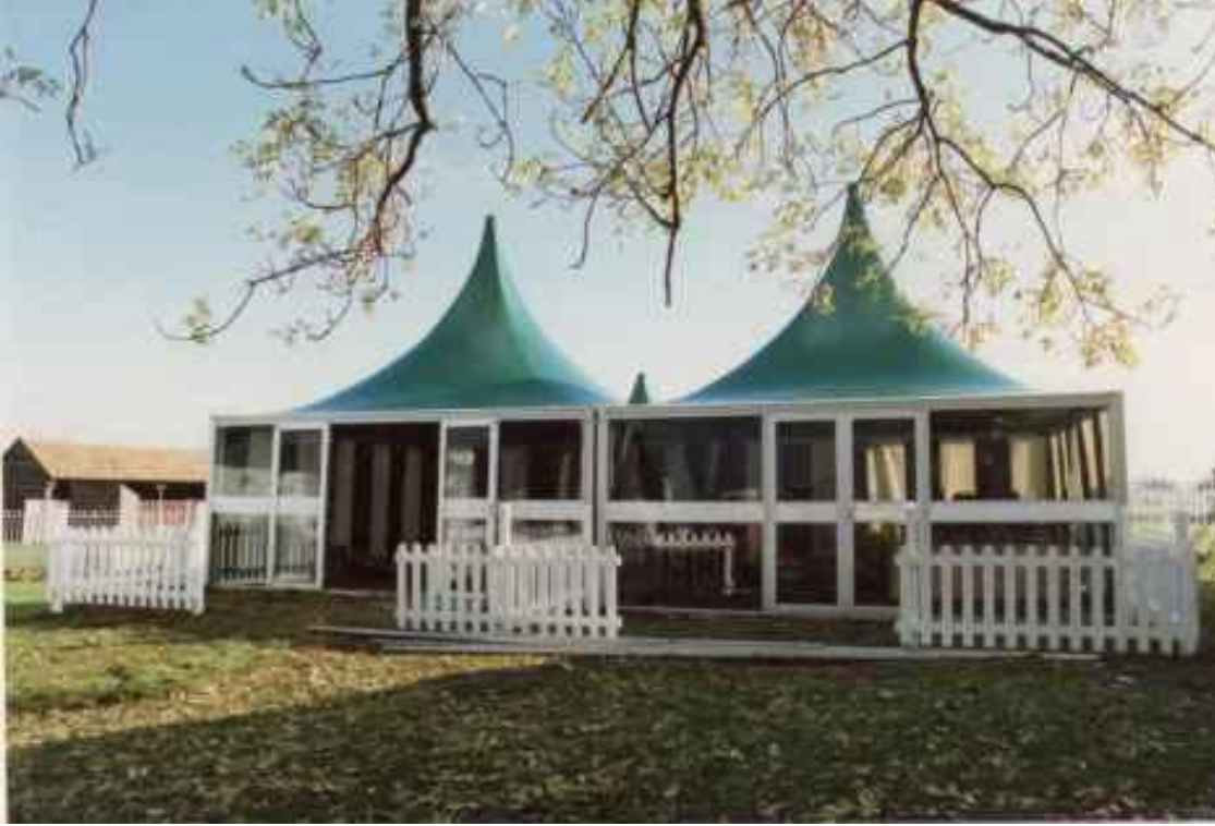
شكل (3-15): قبة مستعارة لأسقف المبنى.
