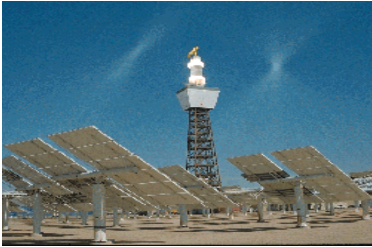
الشكل (2-13): نظام البرج المركزي ذو البؤرة النقطية
