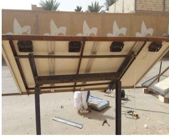
شكل (4-1): الألواح الأربعة مثبتة على الهيكل الحديدي المعدل خصيصاً لهم.
