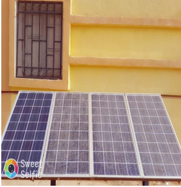
شكل (4-4): عملية التنظيف الدورية للألواح الشمسية الكهروضوئية المستعملة.
