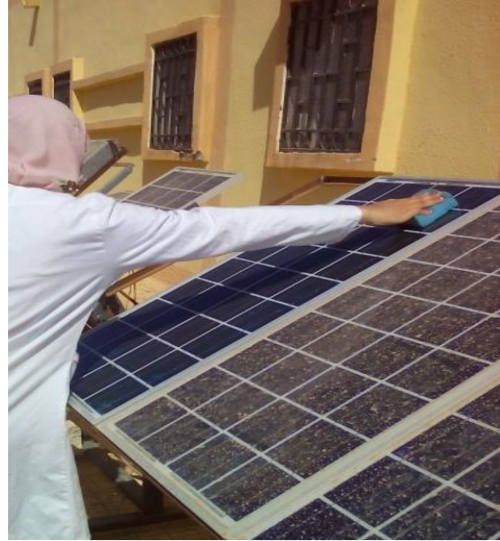
شكل (4-4): عملية التنظيف الدورية للألواح الشمسية الكهروضوئية المستعملة.
