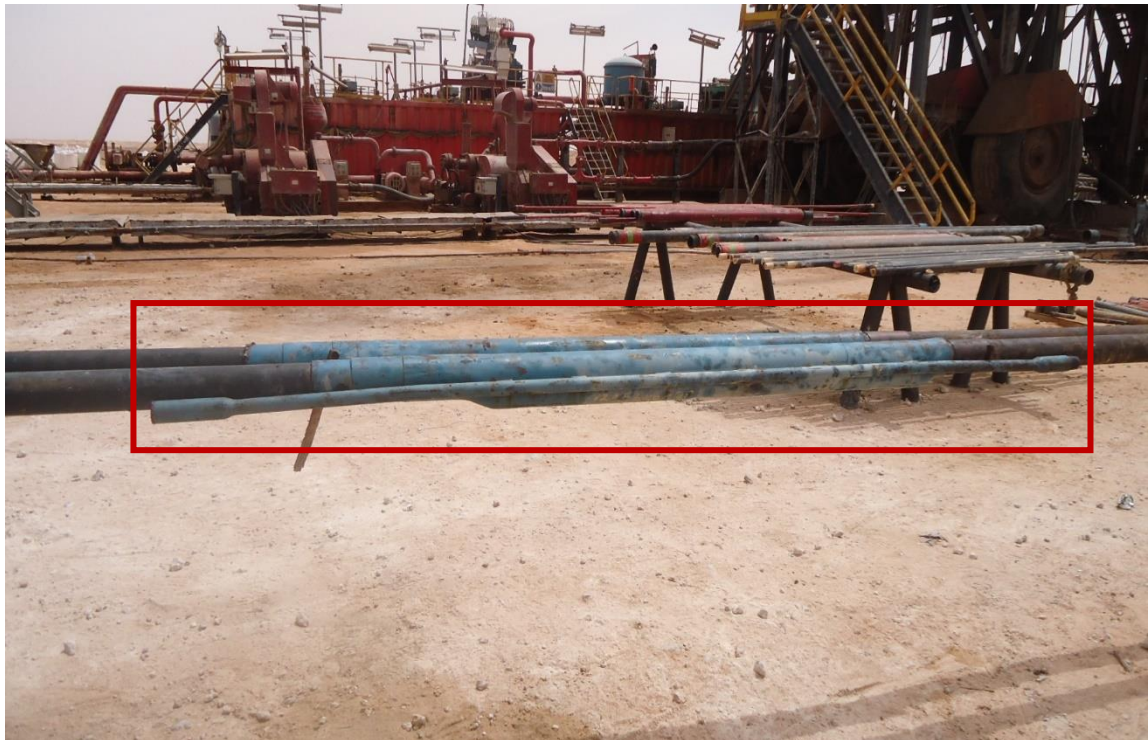
Figure III.2 : SPM pour le GAS-LIFT (2)
