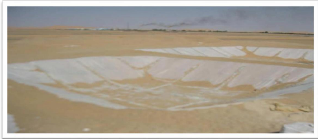
Figure IV.2: Photo de Bourbiers étanche avant le forage.
