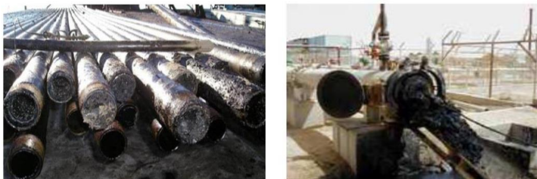
Figure IV. 3: Dépôt d'Asphaltènes dans les Tubings et dans le réseau de collecte.
