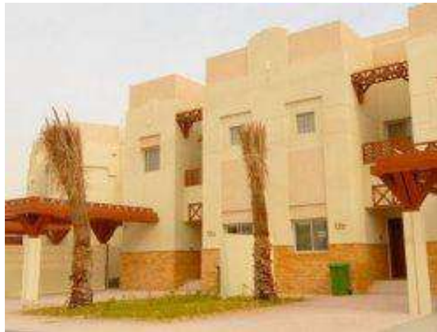
Figure 2.3 : Logement semi collectif (Ouargla)[14]
