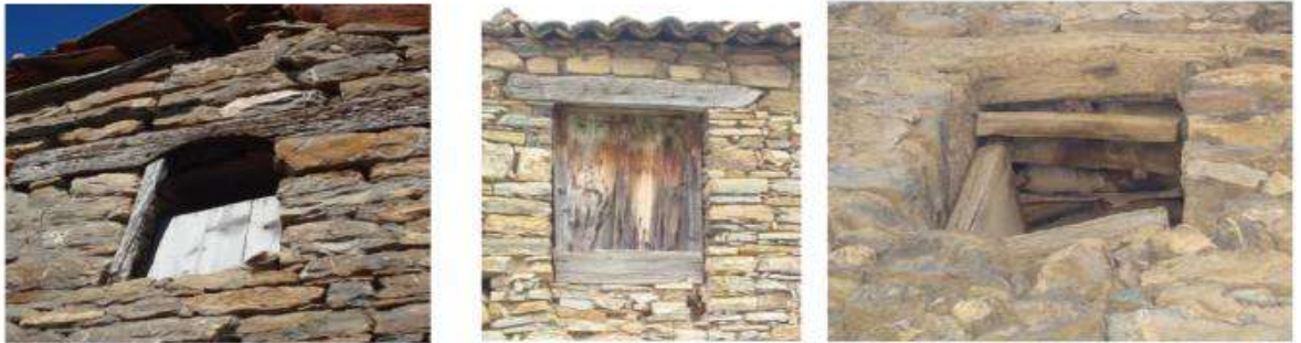
Ces ouvertures sont une simple interruption dans le mur. Elles sont constituées de linteaux en bois A gauche. Village Djebba, Béjaia. Au centre : Mazekwane, Tichy, Béjaia. A droite : Boudjlil, Béjaia
