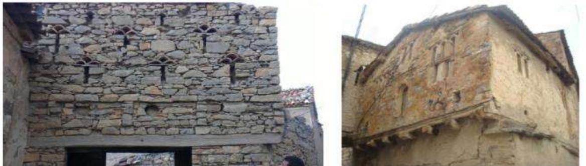
Fenestrons pour l'aération. A gauche : Village la Qallaa d'Ait Abbas, Bejaia. A droite : Ighil Ali, Béjaia.
