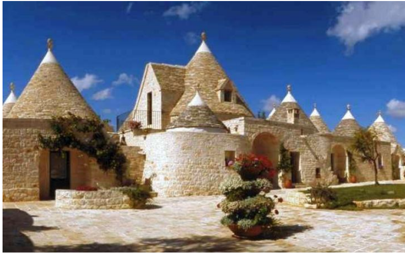
Figure I. 22: Vue des tours dans un hôtel en Italie construits récemment [57]
