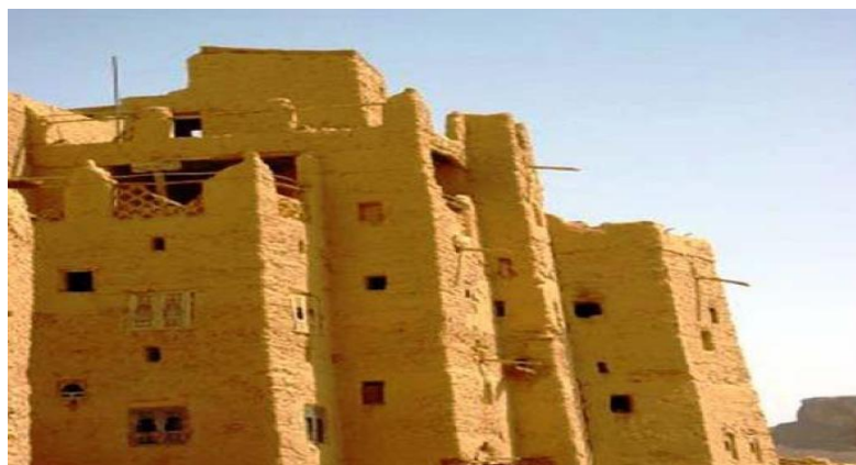
Figure I.27: Trou isolé d'un bâtiment à Al Hajjarayn, Wadi dawau au Yémen [59]
