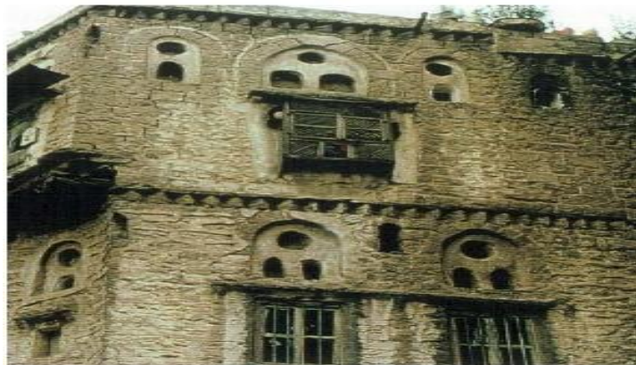
Figure I.14: Usage de matériaux locaux (la pierre) au Yémen [12]
