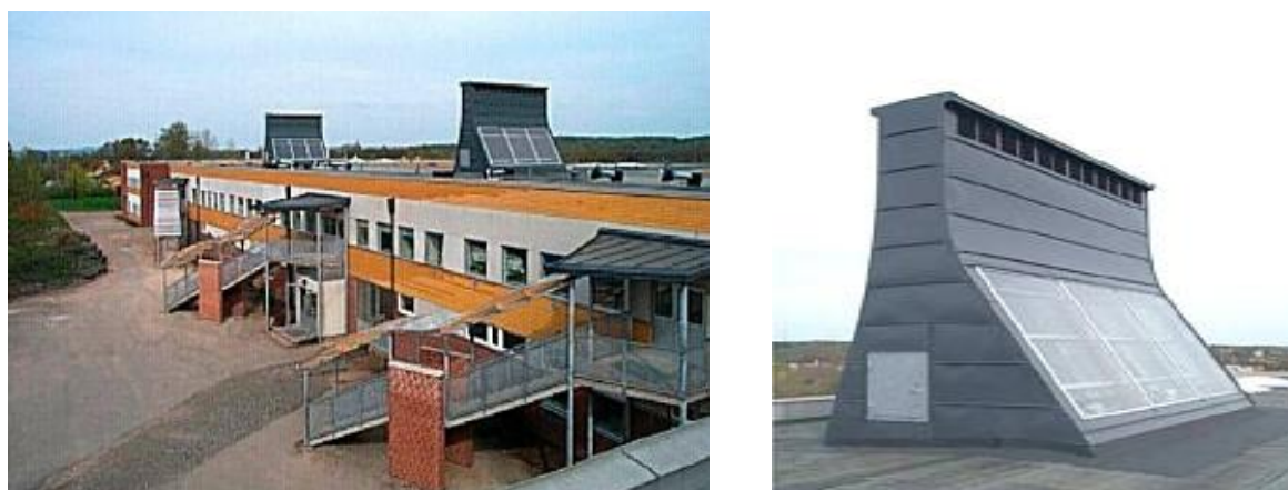
Figure II.14: Présentation d'une cheminée solaire à l'école Tanga [61]
