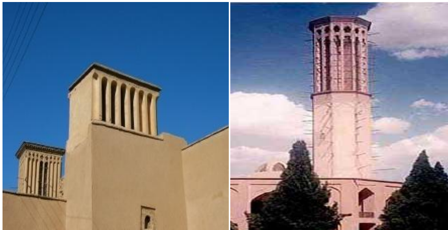
Figure I.29 : Exemple de cheminée de ventilation traditionnelle (tour de vent) en Iran
