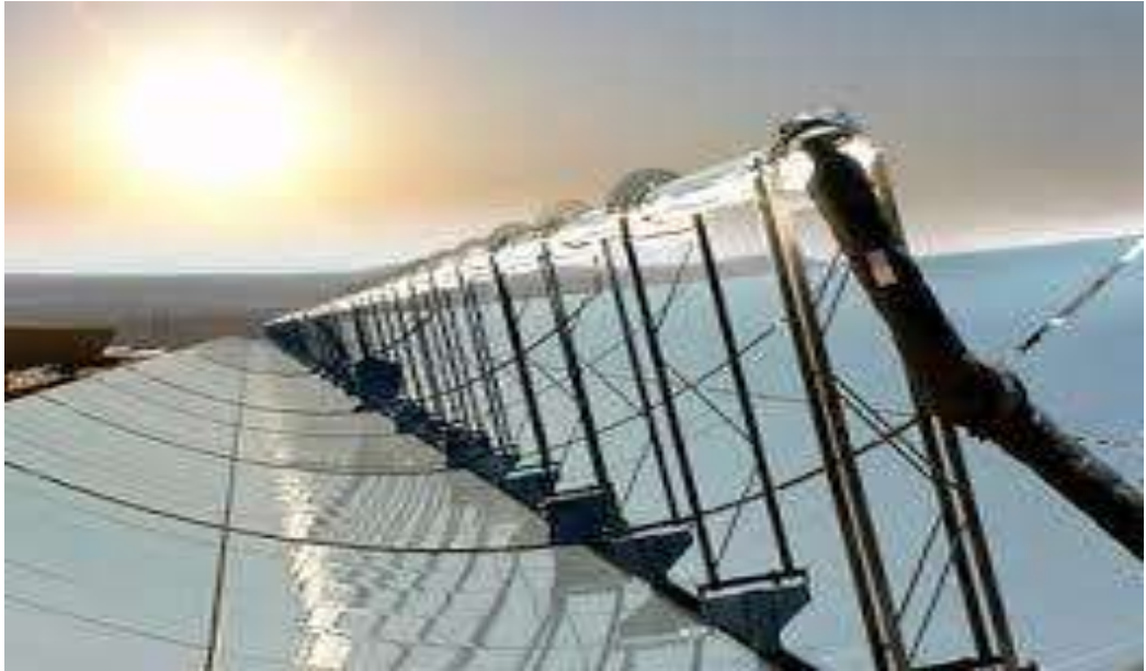
Figure.2.2: Centrales Solaires Cylindro-paraboliques
