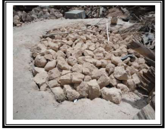
الصورة I.6. : فرن أرضي جاهز قبل الحرق
