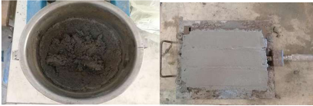
Photo 8 : malaxage et coulage de mortier
