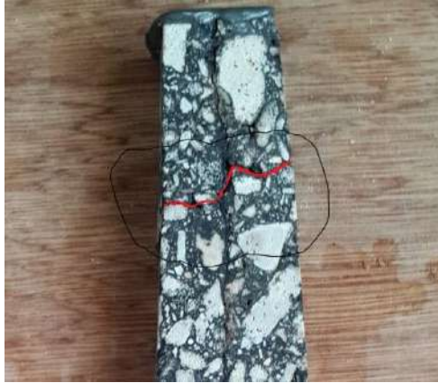
Figure V.24.sans de Fissuration d'éprouvette renforcé par géogrille
