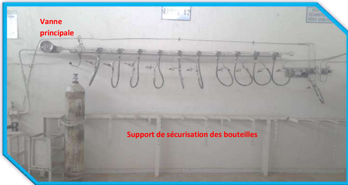
Figure III.08 : Rampe de remplissage
