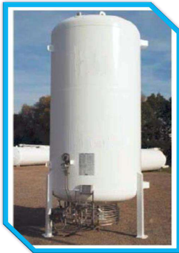
Figure III.01 : Réservoir de stockage LOX MED [7]
