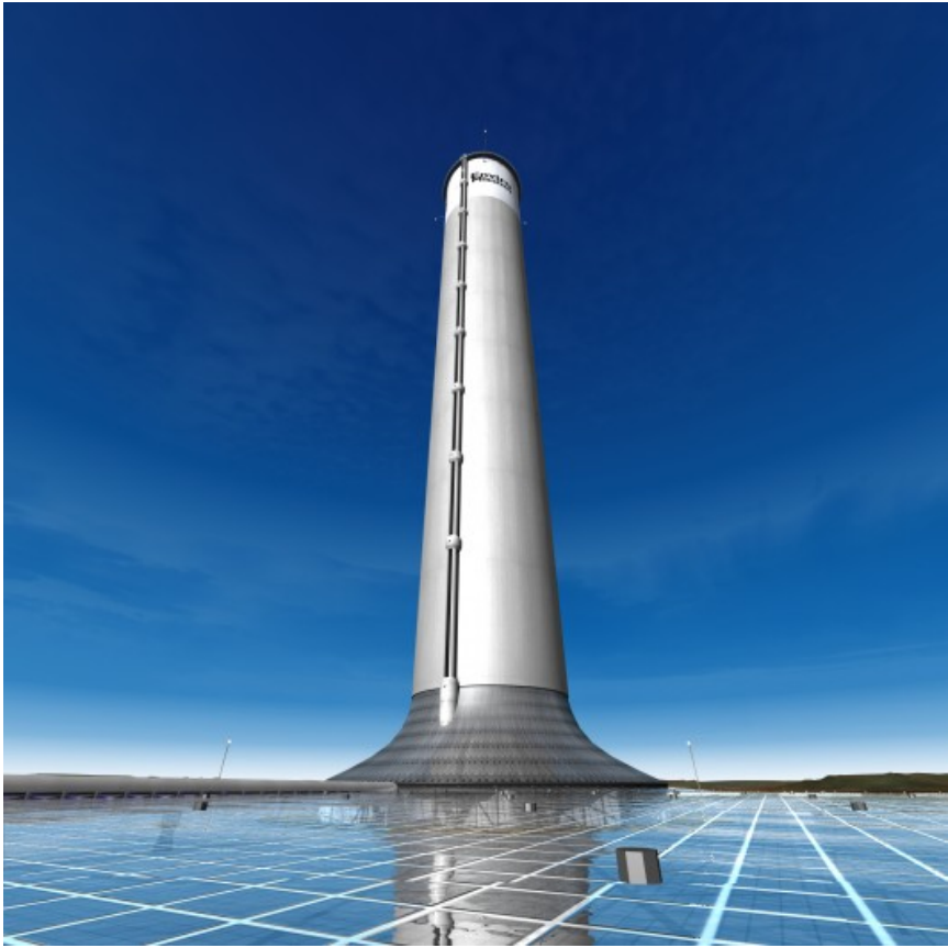
Fig.II. 6: Tour solaire pour la génération d’électricité à Arizona, USA [74]
