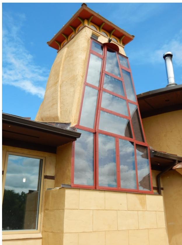
Fig.II. 1: (En haut) Cheminées solaires à l'école Stewart Middle, Washington [67]. (En bas) The Solar Dragon's cheminée solaire, Nord Alberta [68].
