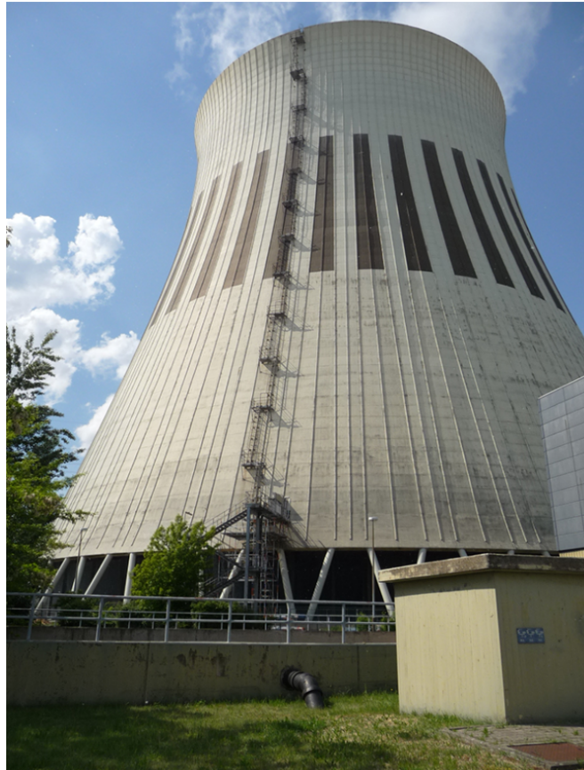
Fig.II. 8: Tours de refroidissement à tirage naturelle en cours de réalisation (les entrées d'air en bas) [75]
