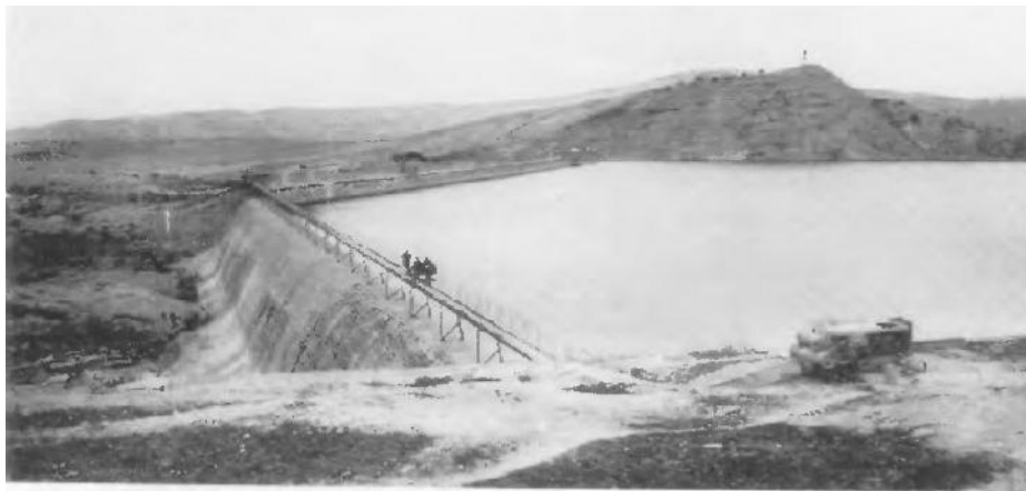
Figure (1,7): Le barrage de l'oued Fergoug avant la catastrophe de 1927
