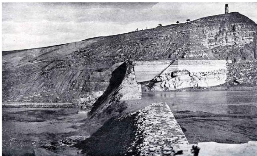
Figure (1,8): Vue du barrage Fergoug après la rupture du 25 novembre 1927
