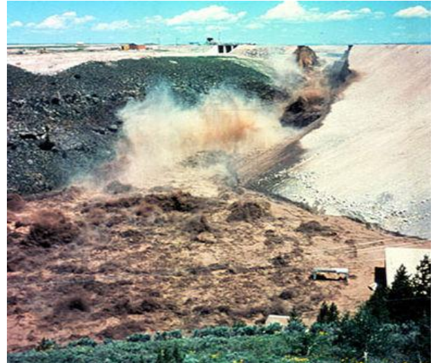
Figure (1,6): Barrage de Teton après la rupture
