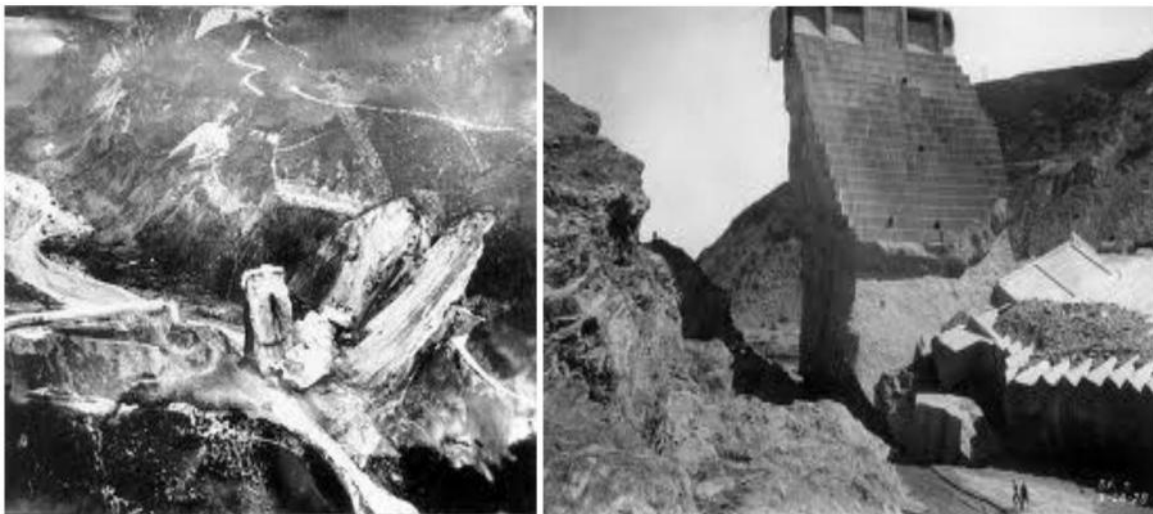
Figure (1,2) : Etat du barrage de St Francis après la rupture
