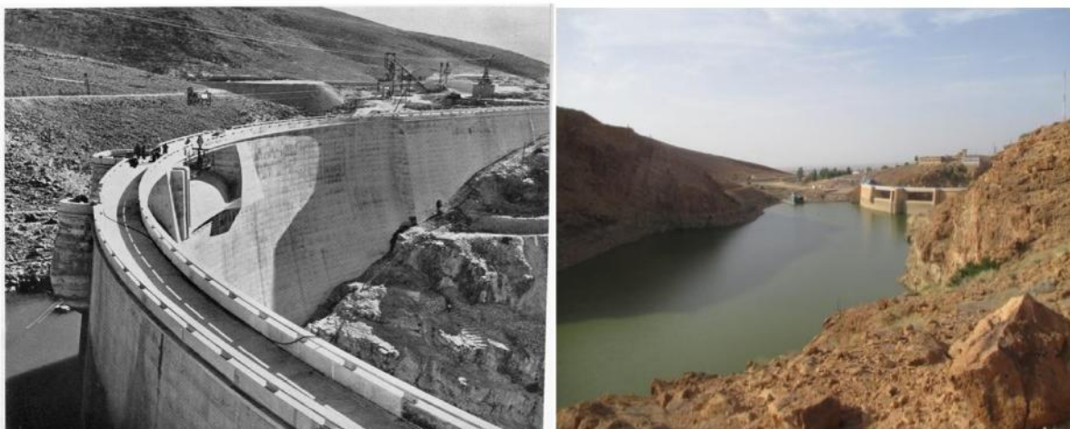
Figure (2,2) : Différentes vues du barrage de Foug El Gherza
