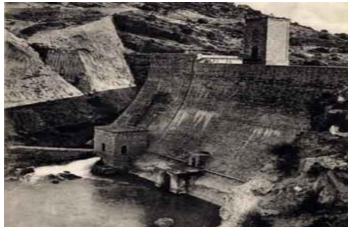
Figure (1,10): Barrage de Cheurfa, après travaux : nouvel appui RD vers l'amont( http://sigoise.free.fr )
