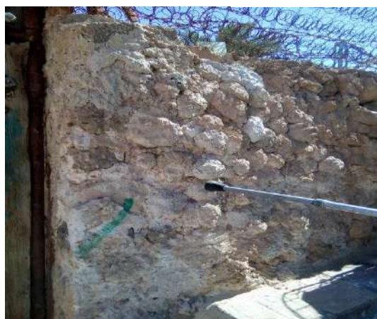
Figure I.7 : Un mur construit avec le Timchemt
