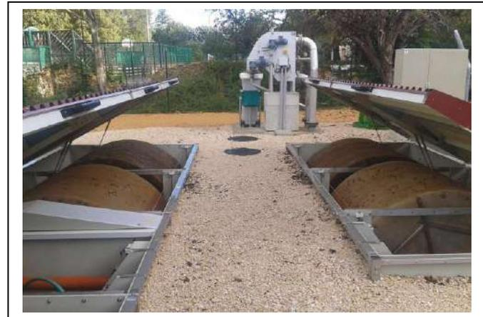
**Figure n° 3 : schéma explicatif du système disques biologiques.**
