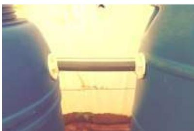
**Figure 39:** Le passage d'eau entre le séparateur mécanique et le biofiltre.
