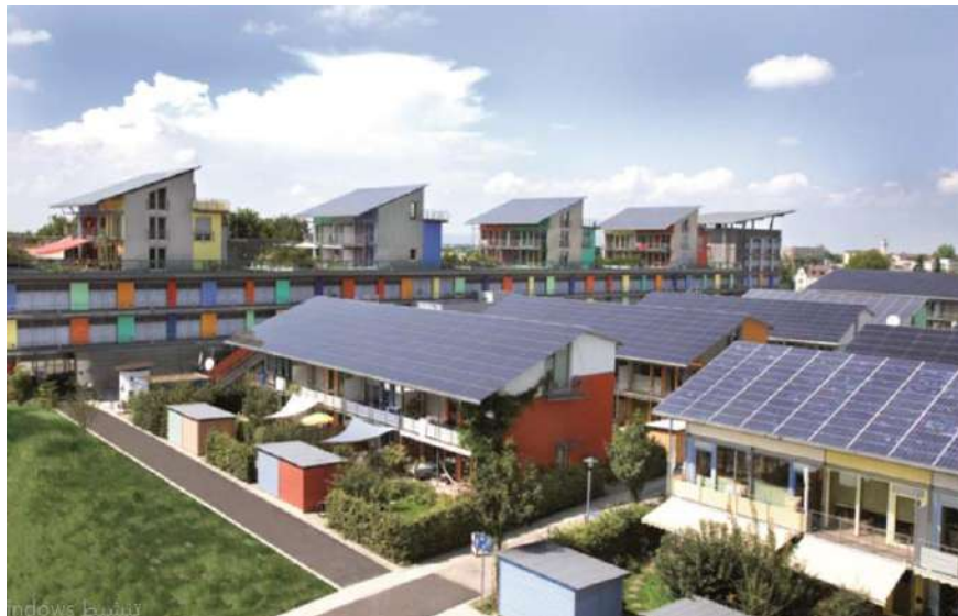
Figure II-4 : Aperçu du lotissement Solarsiedlung de Rold Disch ( www.rolfdisch.de ).
