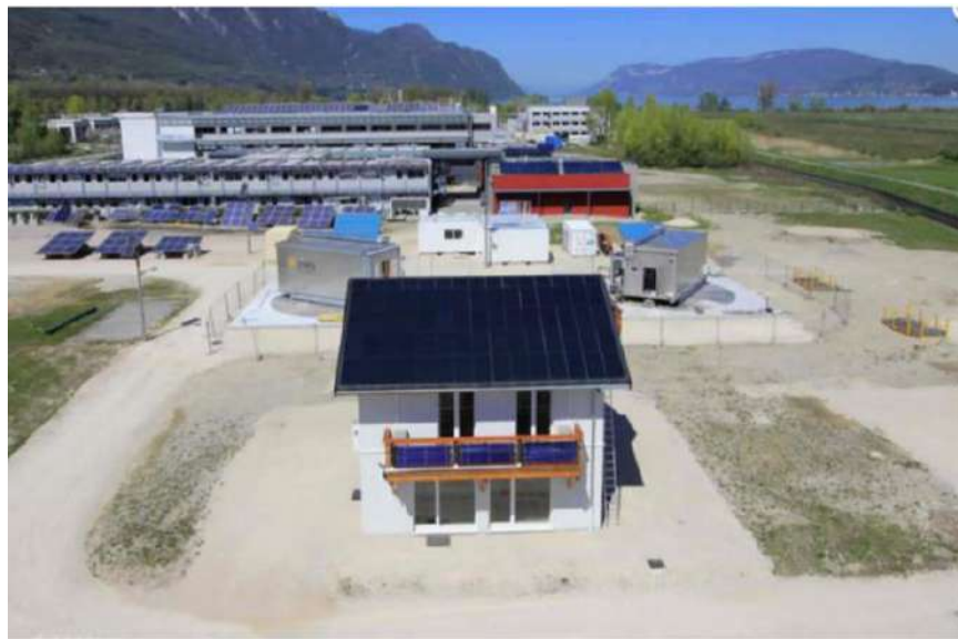
Figure II-2: Maison I-BB de plateforme INCAS à Chambéry [21].
