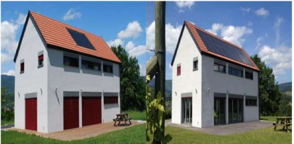
Figure II-5: Façades « Sud » de la maison Chloé originale (gauche), et extension (droite) de la surface de panneaux photovoltaïques pour obtenir la certification « Passive House Plus », tirée de la maison passive (2016)
