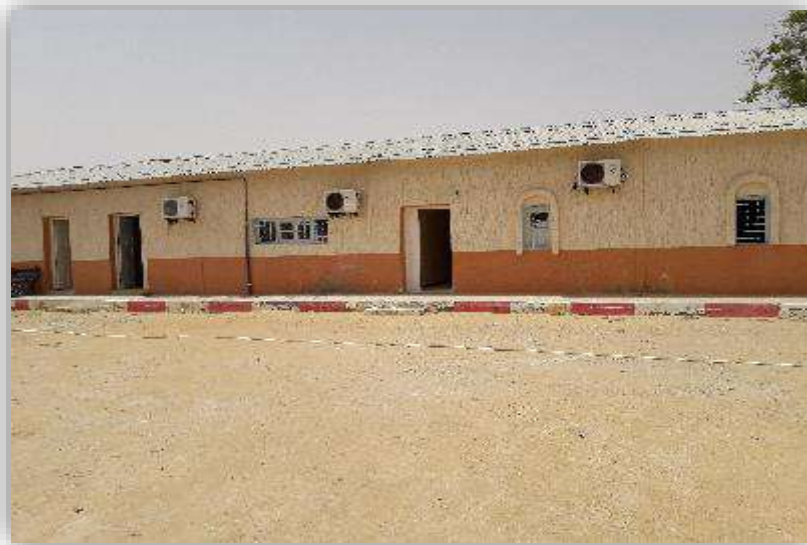
Figure n°11 : Photo de block administratif
