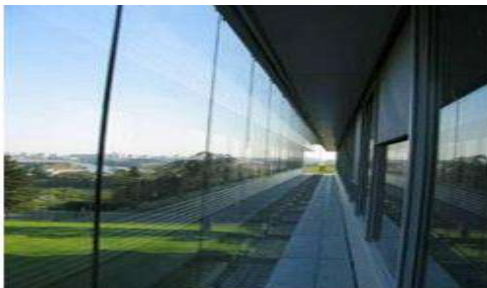
Figure I.9 : Façade a Double peau de l'intérieur. [06]
