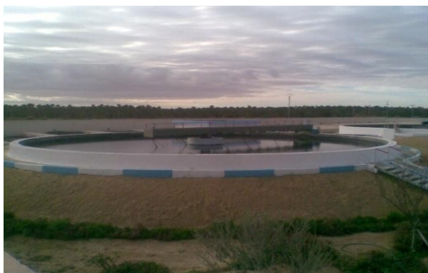
Photo.10: représente un bassin de décantation.
