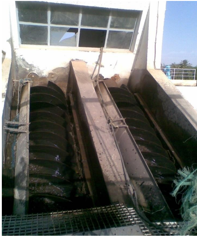
Photo.12 : représente la Vis d'Archimède.
