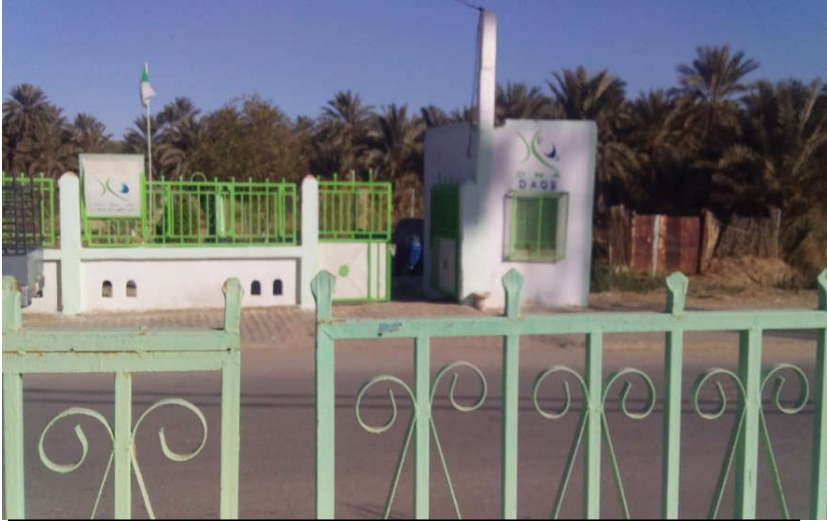
الصورة رقم(11): توضح محطة التصفية بتماسين
