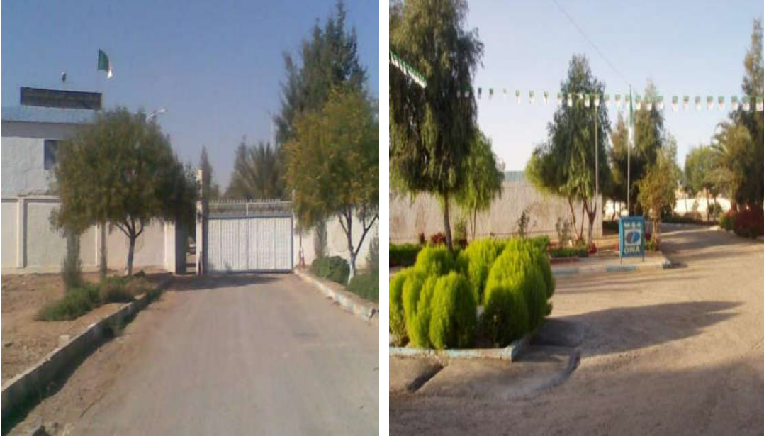
الصورة رقم(10) : توضح محطة التصفية بتقرت
