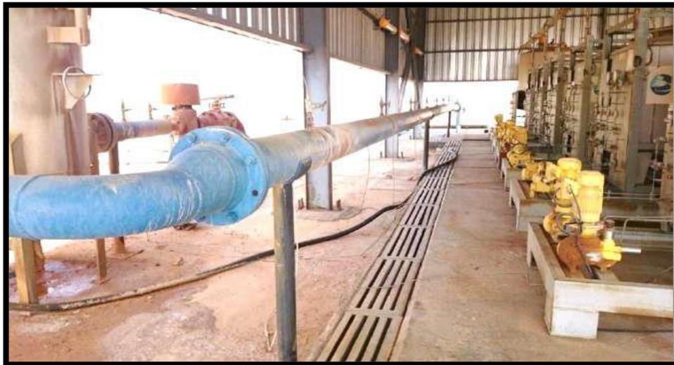
Figure III.3 : Station de traitement d'eau par des produits chimique [5].
