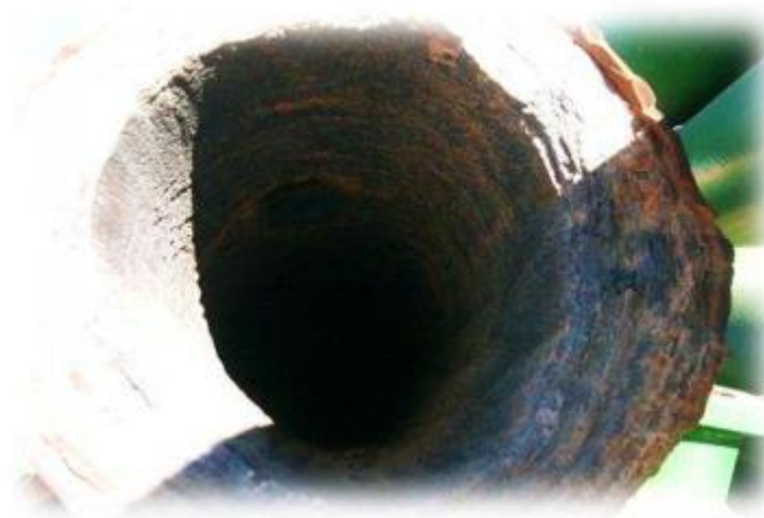
Figure (3.1) : DEPOTS DE \text{CaSO}_4 DANS UNE PIPE DE PETROLE
