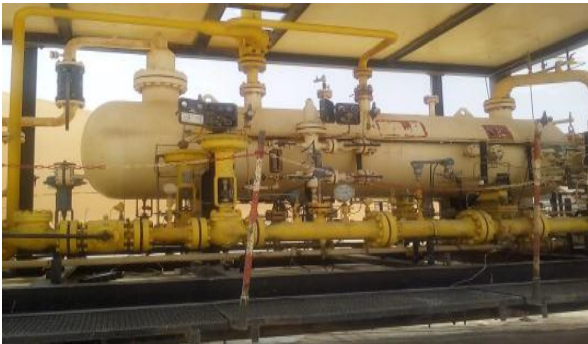
Figure II.9 : Séparateur horizontal mobile d'essais
