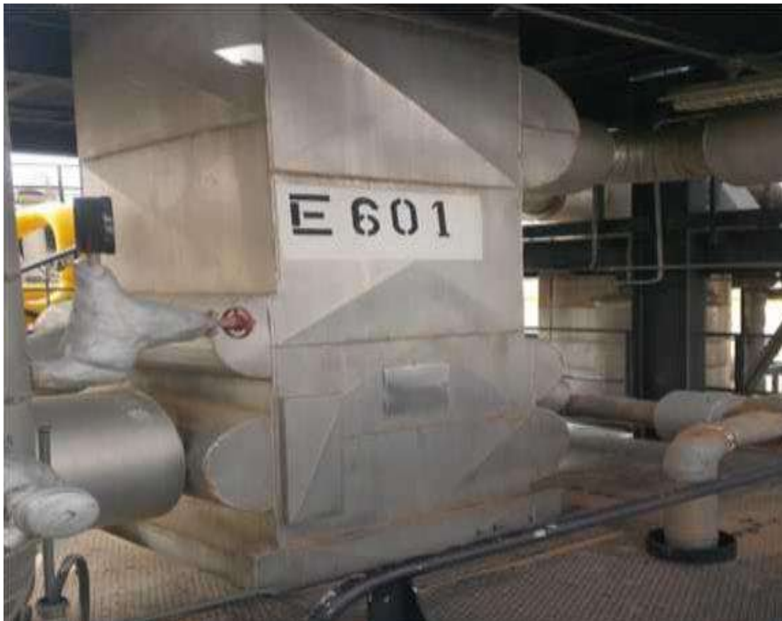
Figure (IV.1) : Echangeur à plaque E601
