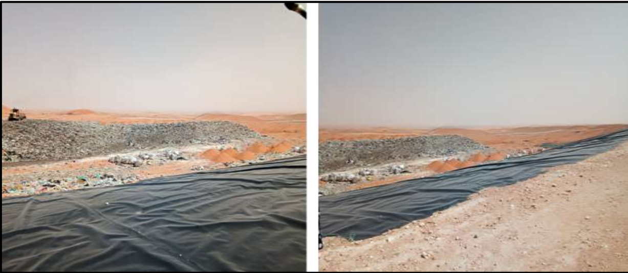
الشكل (1.III): كيفية فرش الأرضية بالغشاء الأرضي (Geomembrane) بمركز الردم التقني، بامنديل- ورقلة.
